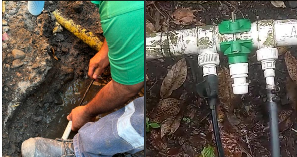
Ilustración 1, Conexiones fraudulentas
