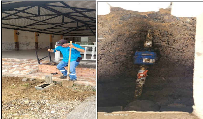
Ilustración 2, Instalación micromedidores
