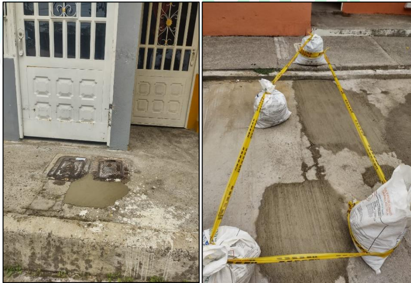
Ilustración 5, Reparcho de fugas
