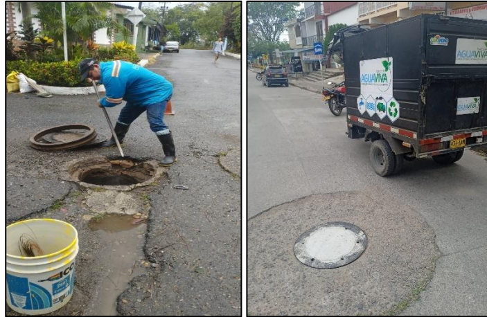
Ilustración 20, Cambio de tapas alcantarillado sanitario área urbana
