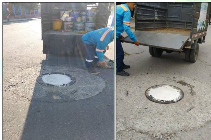
Ilustración 21, Cambio de tapas alcantarillado sanitario área urbana
