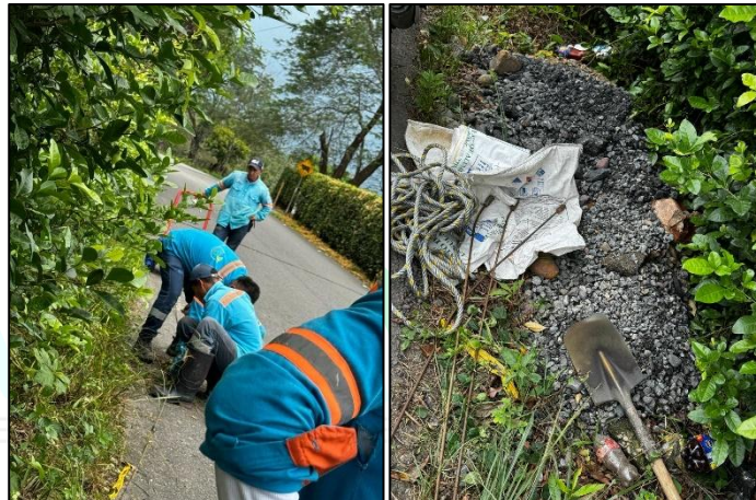
Ilustración 15, Alcantarillado sanitario entrada PTAR
