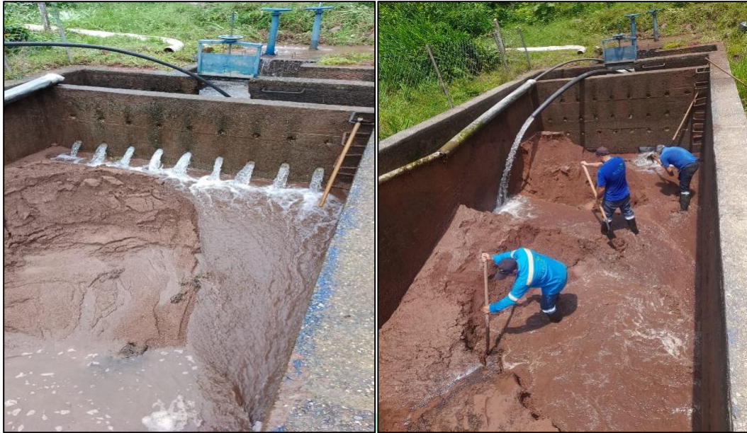
Ilustración 10 Limpieza desarenador
