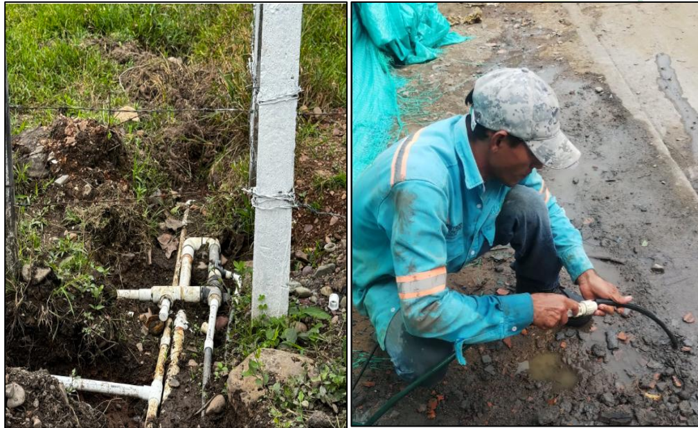
Ilustración 7, Conexiones fraudulentas área rural
